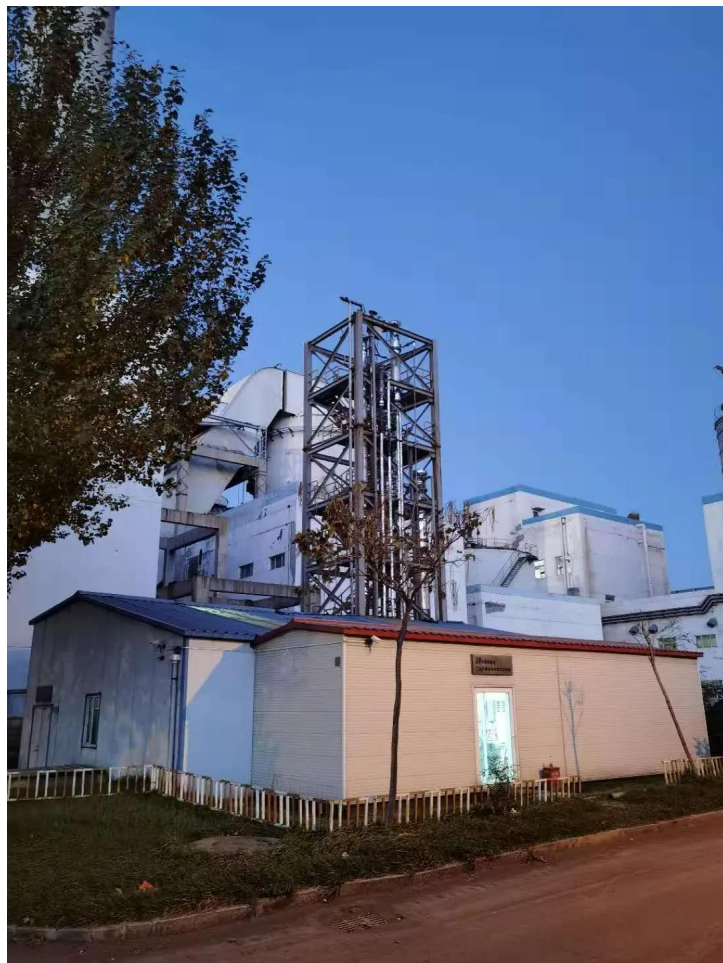
中国首个1000吨/年相变碳捕集装置 China's first 1000 tons/year phase change carbon capture test unit
